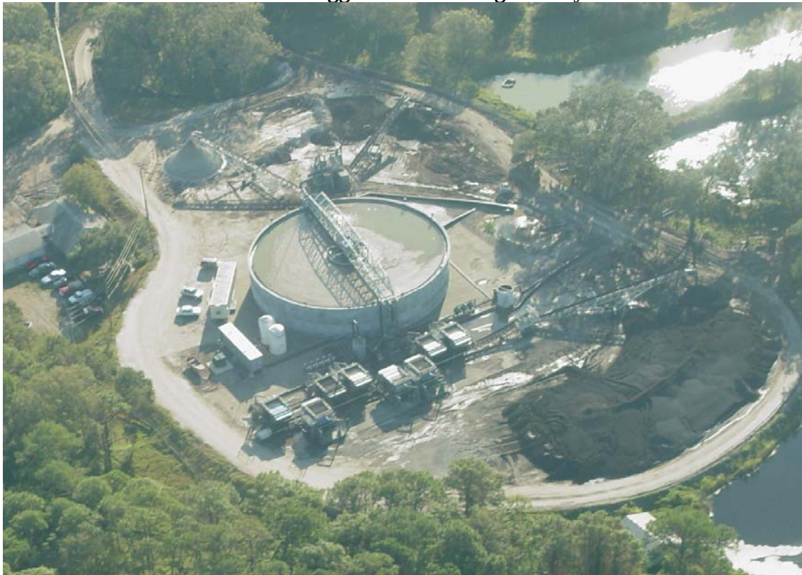
Figure 14 Lake Maggiore Dewatering Facility
